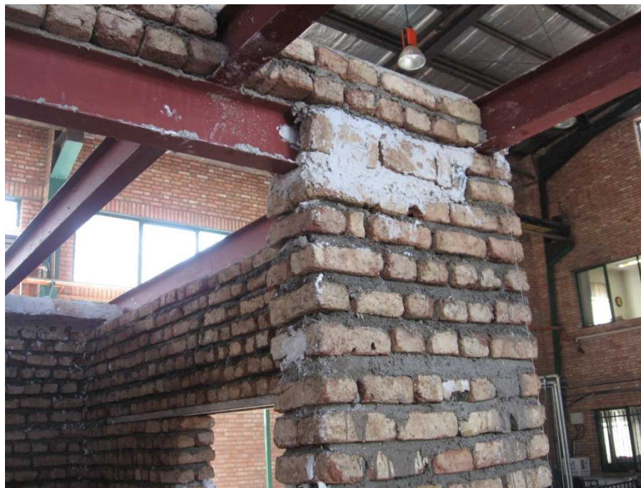
عدم وجود اتصال مناسب بین اجزاء سقف
